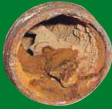
**Antes:** La corrosión e incrustaciones de cal forman depósitos irregulares en la pared interna de la tubería causando pérdidas de presión y caudal del agua.
