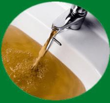
**Agua marrón:** La reducción del caudal del agua y el mal funcionamiento de grifos, termos eléctricos, calderas y calentadores de agua son los primeros síntomas de tuberías afectadas que pueden derivar en posibles roturas o picaduras de las mismas.
