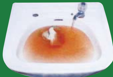
Agua marrón – la reducción del caudal del agua y el mal funcionamiento de grifos y calentadores de agua son los primeros síntomas de tuberías afectadas, que pueden derivar en roturas o picaduras de las mismas.
